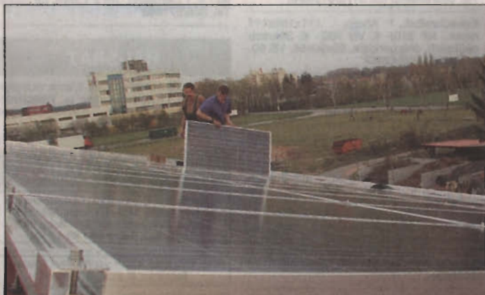
Landwirt Arno Eckert bei der Montage eines Photovoltaik-Moduls auf dem Dach seiner Maschinenhalle. Foto: pm
