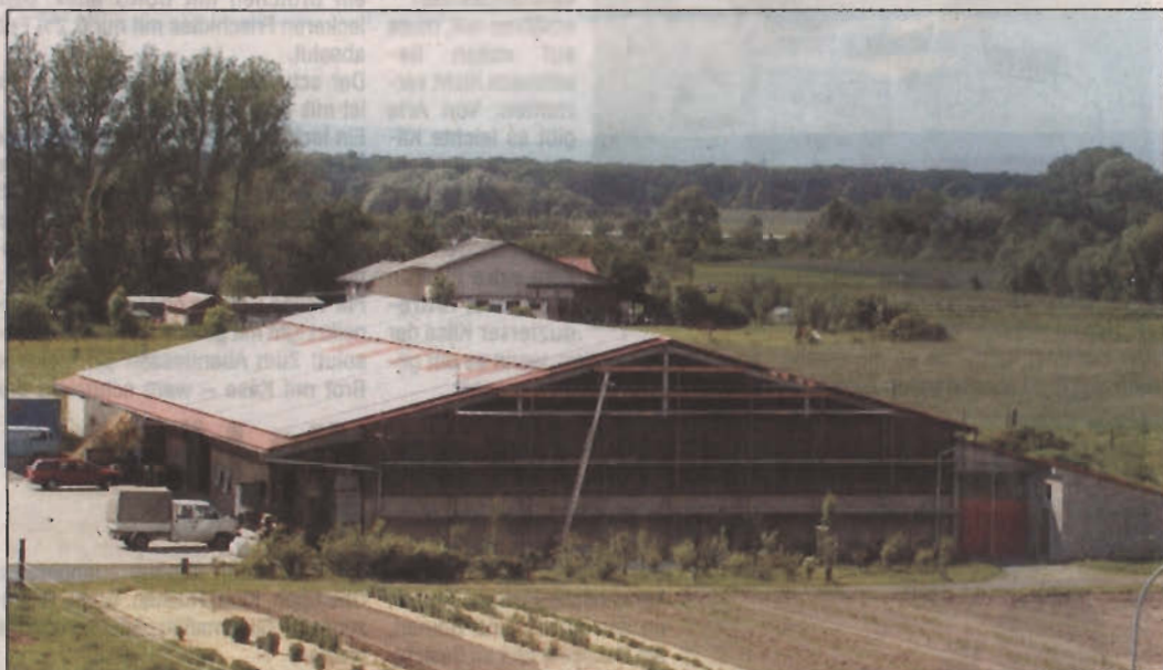
Auf 750 Quadratmeter Dachfläche erstreckt sich in Egelsbach eine der größten privaten Solaranlagen Hessens. Foto: Kostka
